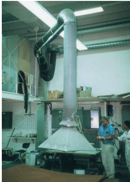
Abbildung 5: Flexible Punktabsaugung für Flächen (Overmann)
