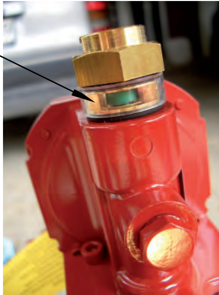
Abb. 12: Sichtanzeige (grün: Normalbetrieb, rot: Gaszufuhr unterbrochen)
