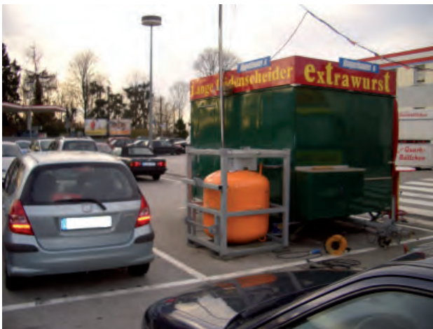
Abb. 48: Beispielhaftes Flüssiggas-Fass (hier: Fass mit einem Füllgewicht von 320 kg → ca. 10-fache Kapazität einer 33-kg-Flasche) mit fehlendem Anfahrschutz sowie Schutzbereiche nicht eingehalten
