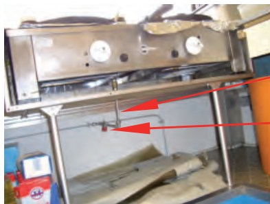
Abb. 18: Crêpe-Backgerät mit Anschluss an eine Rohrleitung und Absperreinrichtung
